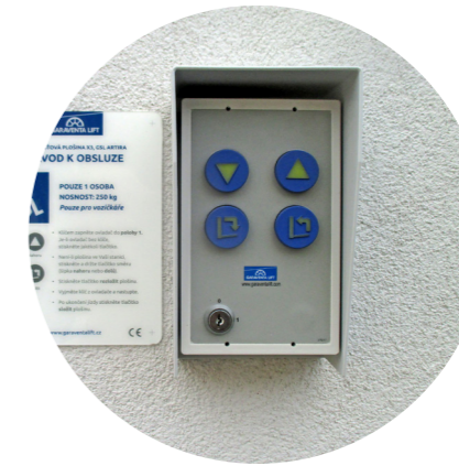
Ovladače plošiny jsou bezdrátové
