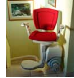
2. Otočná sedačka Uvolněním páčky lze sedačku otočit o 70° v horní stanici a umožnit tak snadný nástup a výstup.
